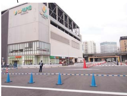
通行誘導カラーコーン
